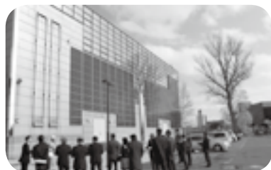
体育館南側壁面に設置した太陽光ソーラーパネル
