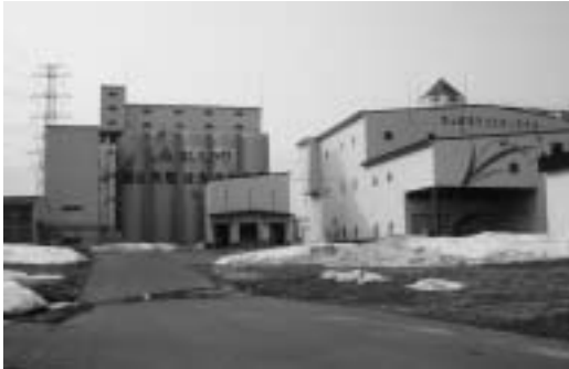
米・麦乾燥調製貯蔵施設
