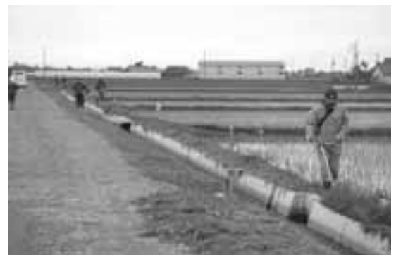
草刈り等で用排水路は維持管理されています。
