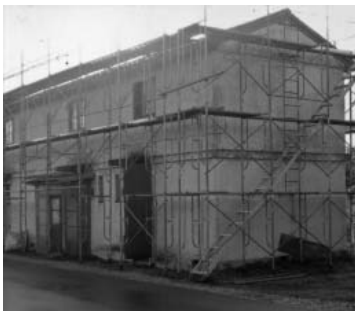
町営住宅の修繕など住民生活に直結した予算を望む(末広団地の修繕現場)
