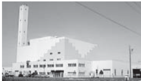
北石狩衛生センター（石狩市厚田区）
