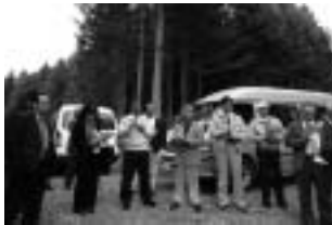
森林総合研究所分収造林地作業道の新設工事現場
