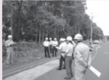
スターライト地区の工事現場を視察
