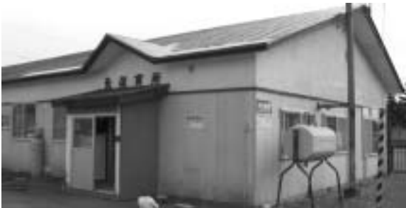
北保育所 (昭和四十五年建設)
