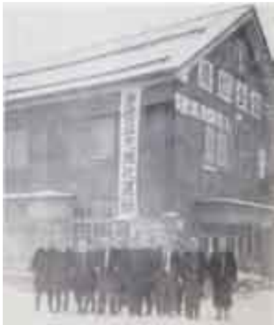
昭和25年当別駅前落成の中央配給所 (購買店舗と会議室)
