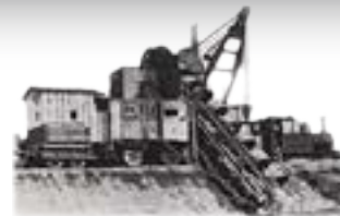
石狩川新水路掘削 新型の土木機械 昭和初期（エキ
