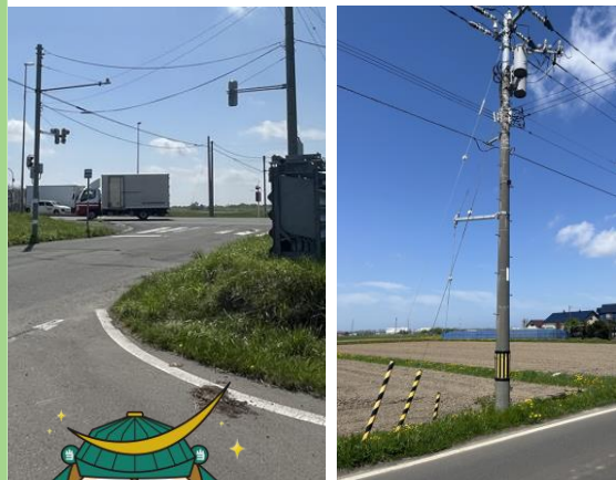
LiDARセンサー設置予定場所
