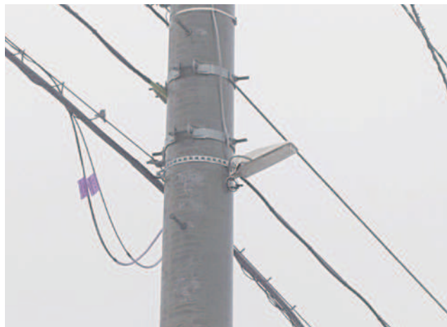
LED化された街灯
