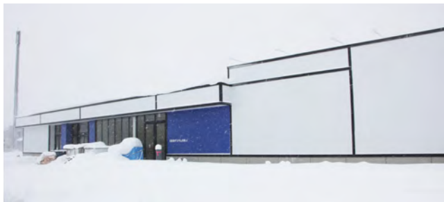
建設中のサッポロドラッグストア（太美町）
