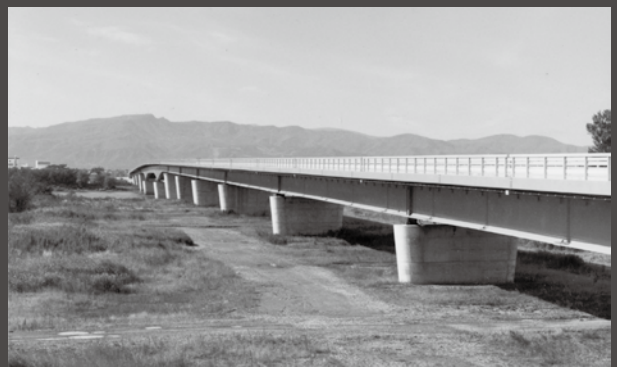
当別町と札幌市を直結した札幌大橋(手前が当別町側)
