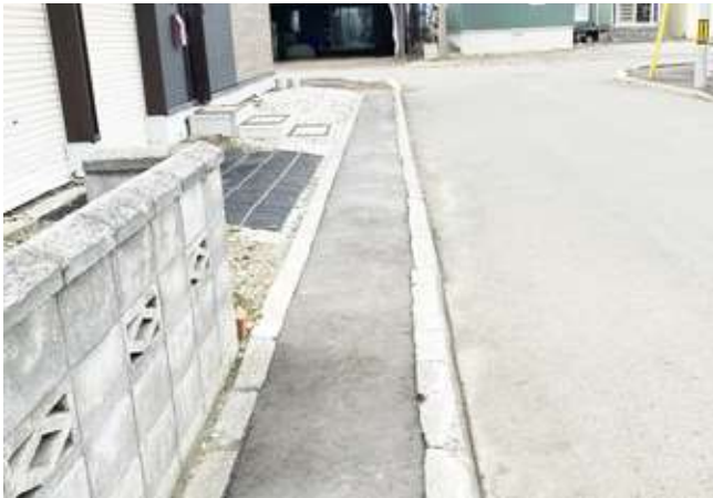
修繕された歩道
