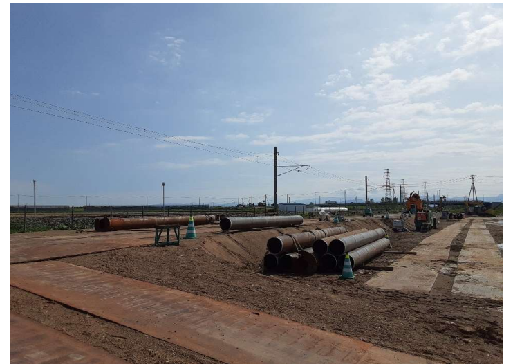
駅前広場 全景 (地上から)
