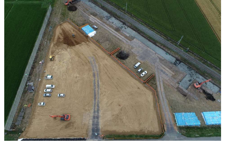
駅前広場 全景 (上空から)
