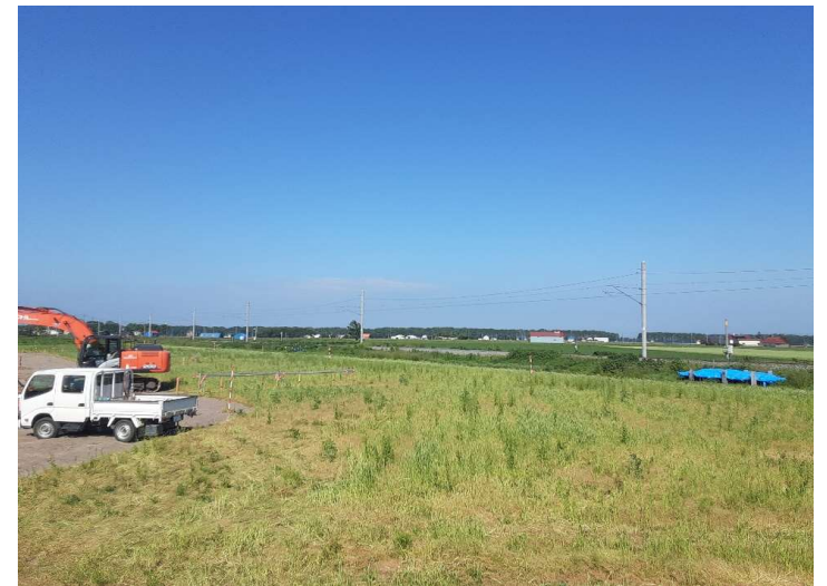
駅前広場 全景 (地上から)
