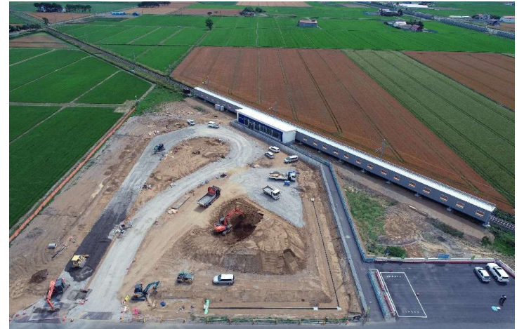
駅前広場 全景（上空から）
