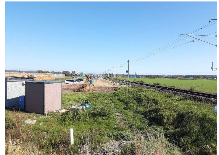
駅舎・乗降場 全景 (地上から)
