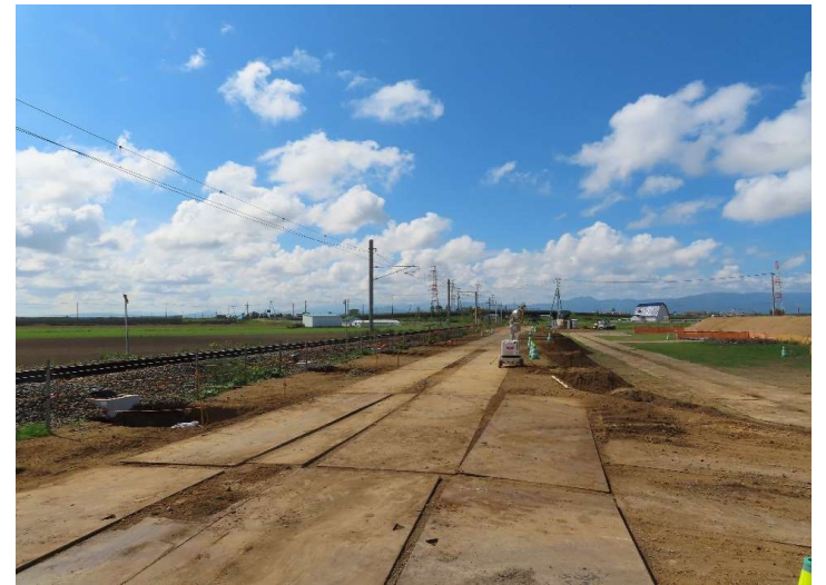
駅前広場 全景 (地上から)
