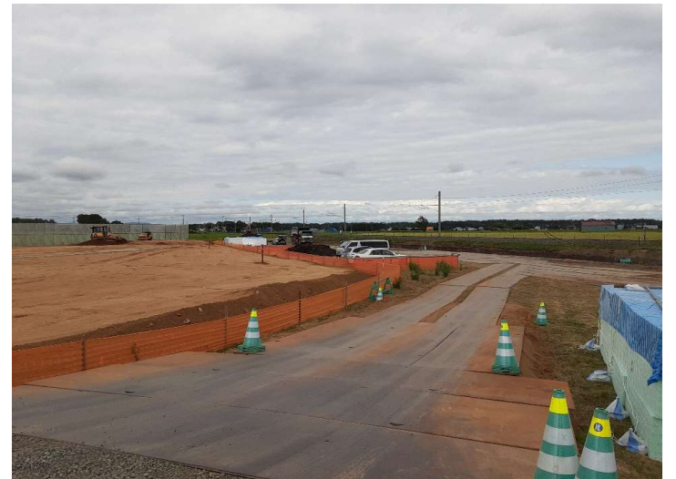
駅前広場 全景 (地上から)
