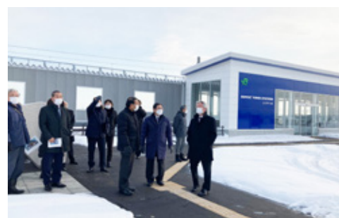
地中熱を活用したロードヒーティング
