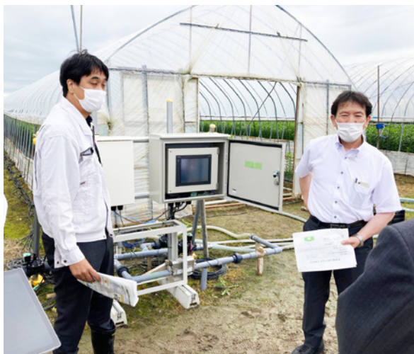
花き生産に導入された自動かん水システム（弁華別）
