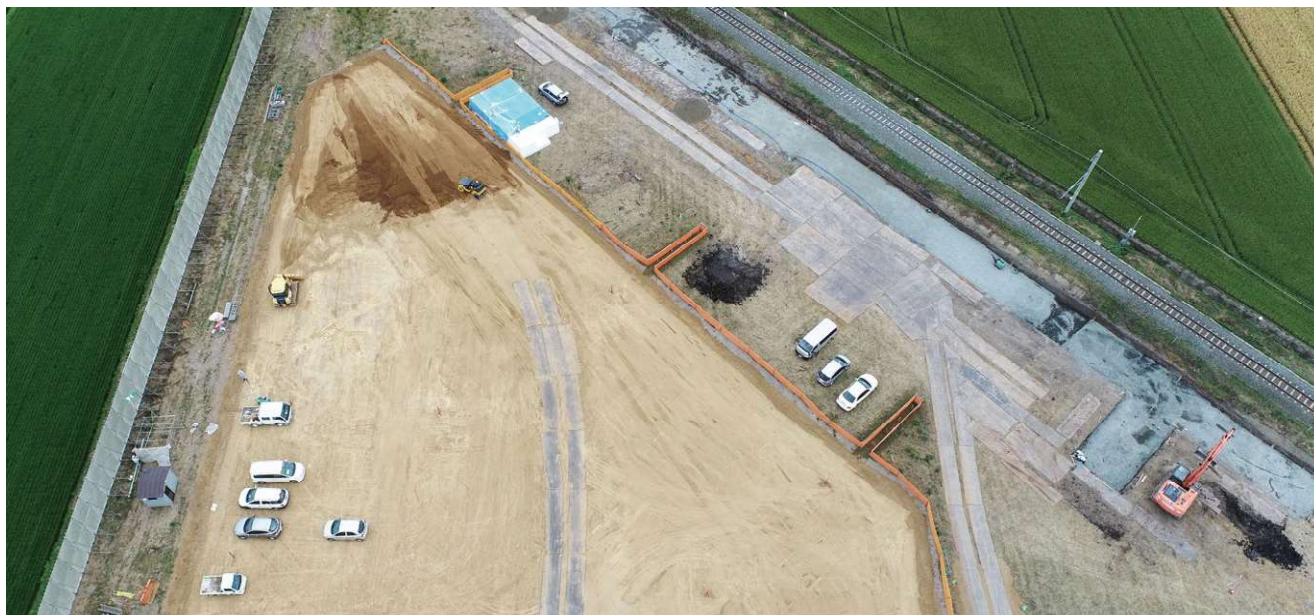
新駅建設現場上空
