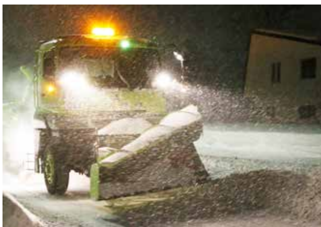
夜間の除雪作業の様子
