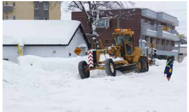
除雪作業の様子
