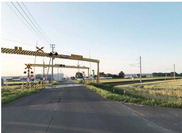
新駅建設予定地付近
