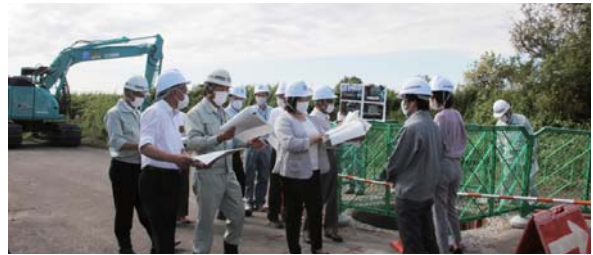
下水道管更新工事現場 (太美北)
