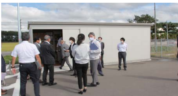
道の駅の防災倉庫 (当別太)
