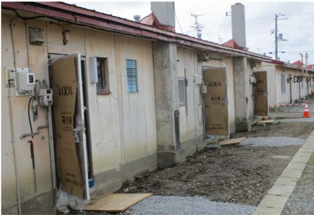
改修中の東町団地
