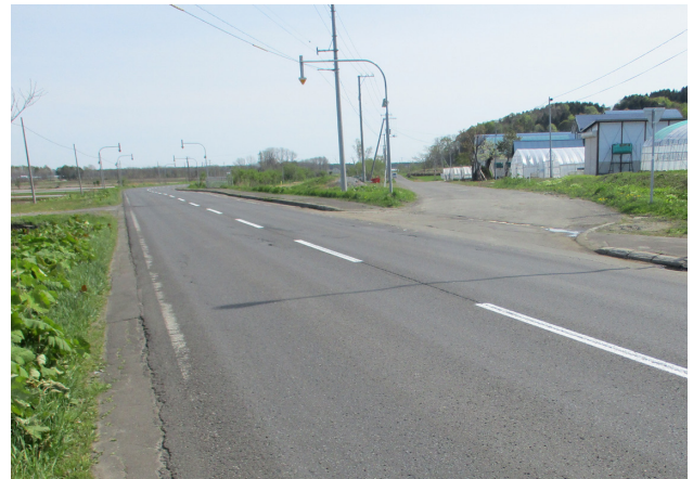
国道275号線（現在は右折レーンがない）
