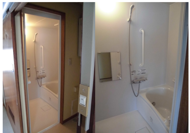
東町団地に設置したユニットバス
