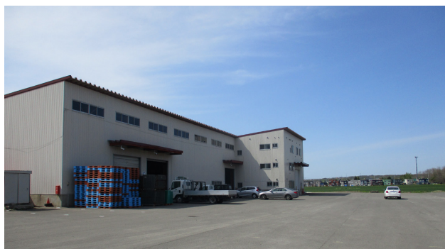
南瓜集出荷貯蔵施設（既存施設の改修と既存施設に向かって右側のスペースに 1 棟新設する。）
