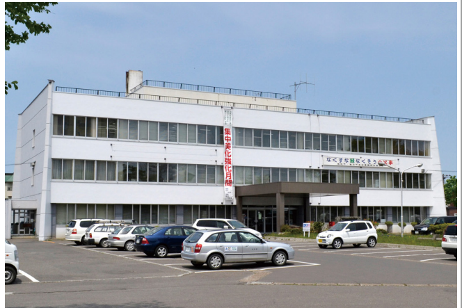
昭和45年に建設された当別町役場庁舎
