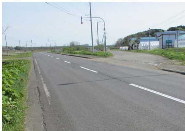
国道275号線（現在は右折レーンがない）
