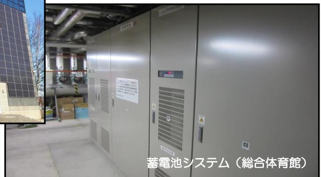
災害等の停電時において、新エネルギー（太陽光及び風力等）による電力を、蓄電池システムから防災拠点の特定負荷（照明や空調設備）へ供給し、施設機能を維持
