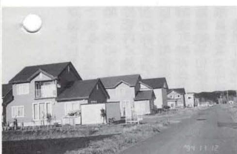
住宅建設が進む太美地区
