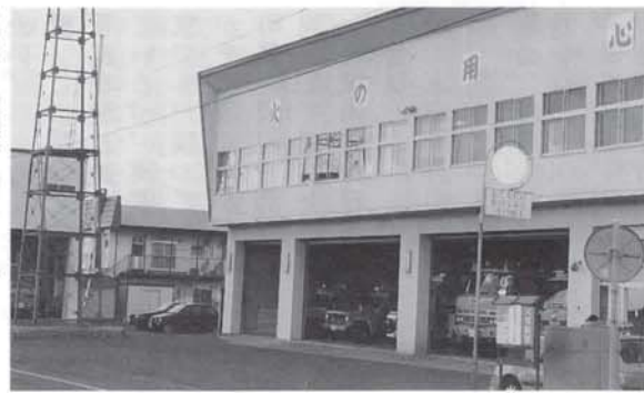
改築・改善が求められる消防庁舎
