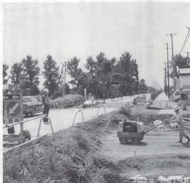
町道スウェーデン大通線 道路改良工事
