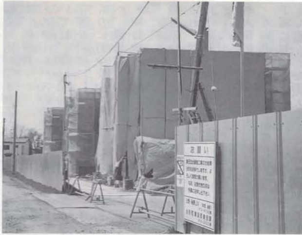
建設が進む春日団地
