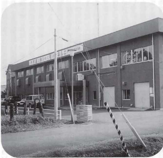
老朽化が進んでいる浄水場
