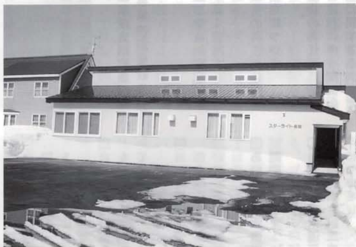
一町内会一会館の建設を (平成12年11月完成したスターライト会館)
