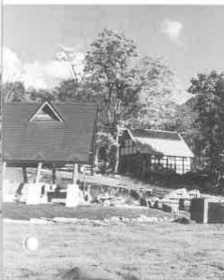
▲道民の森建設事務所を開設 当別林務署内に事務所が開設され、平成2年秋一部オープンを目指し工事も急ピッチで進められています。
