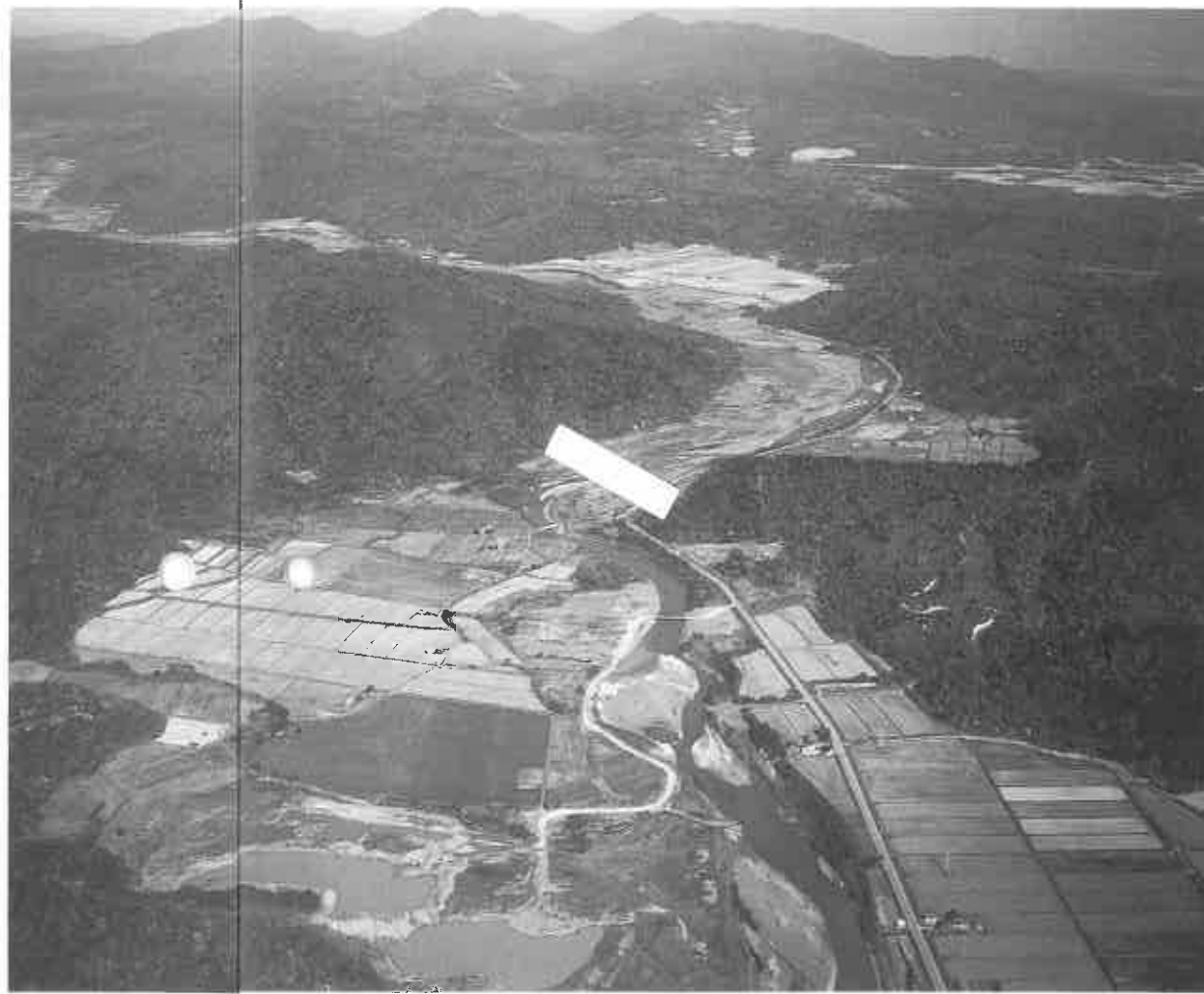
当別ダム建設予定地（青山地区）白線がダムサイト予定場所
