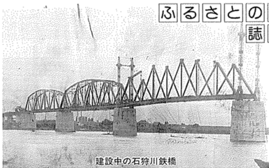
建設中の石狩川鉄橋
