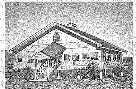
▲中小屋スキー場管理棟を建設 木造1階建て、床面積が268平方メートルで、約100人収容の管理棟（ロジ）などが、スキー場のオープンまでに完成します。
