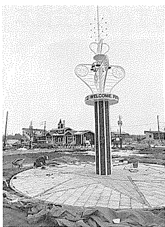
スウェーデンプラザ整備事業着工～メインの「白夜の広場」や「シンボルモニュメント」などが、今年3月中旬に完成。
