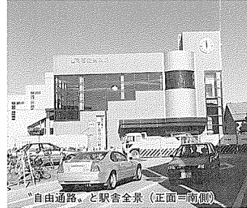
自由通路と駅舎全景(正面・南側)
