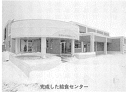
完成した給食センター
