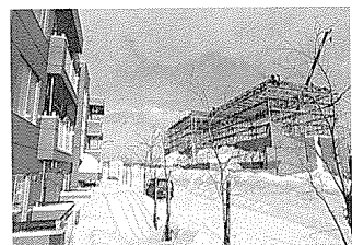
建設が進む春日団地の建替
