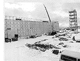
建設が進む消防庁舎 10年度完成を目指す 右端は副訓練塔
