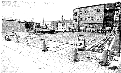
▶建設中の「まちの駅 アウル」
