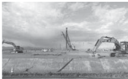
急ピッチで進む道の駅工事 (H 28. 10. 10 撮影・本人提供)
