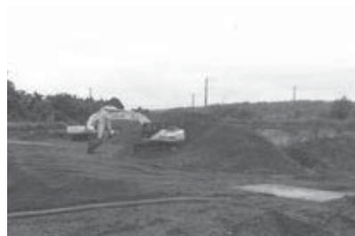
弁華別神社横の土砂採掘跡地 (H 27. 9. 13 撮影・本人提供)
