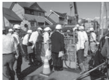
下水道管工事の視察(太美地区)
