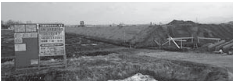
(仮称) 当別町道の駅載荷盛土の様子
